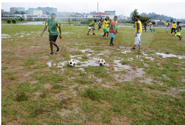
a) Mauvais drainage entraînant une perte de la couverture herbeuse.
