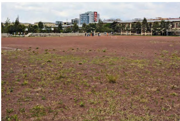
Envahissement typique d'une surface en gravier par de l'herbe et des broussailles
