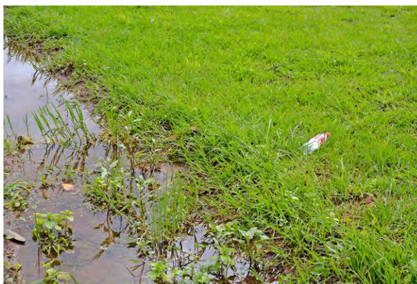
b) Mauvais nivellement, mauvais drainage et mauvaises herbes.
